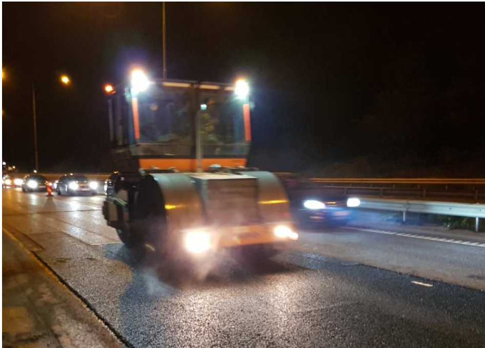
Figur 28. Packning av ABS 16 70/100 med 50%RA.
