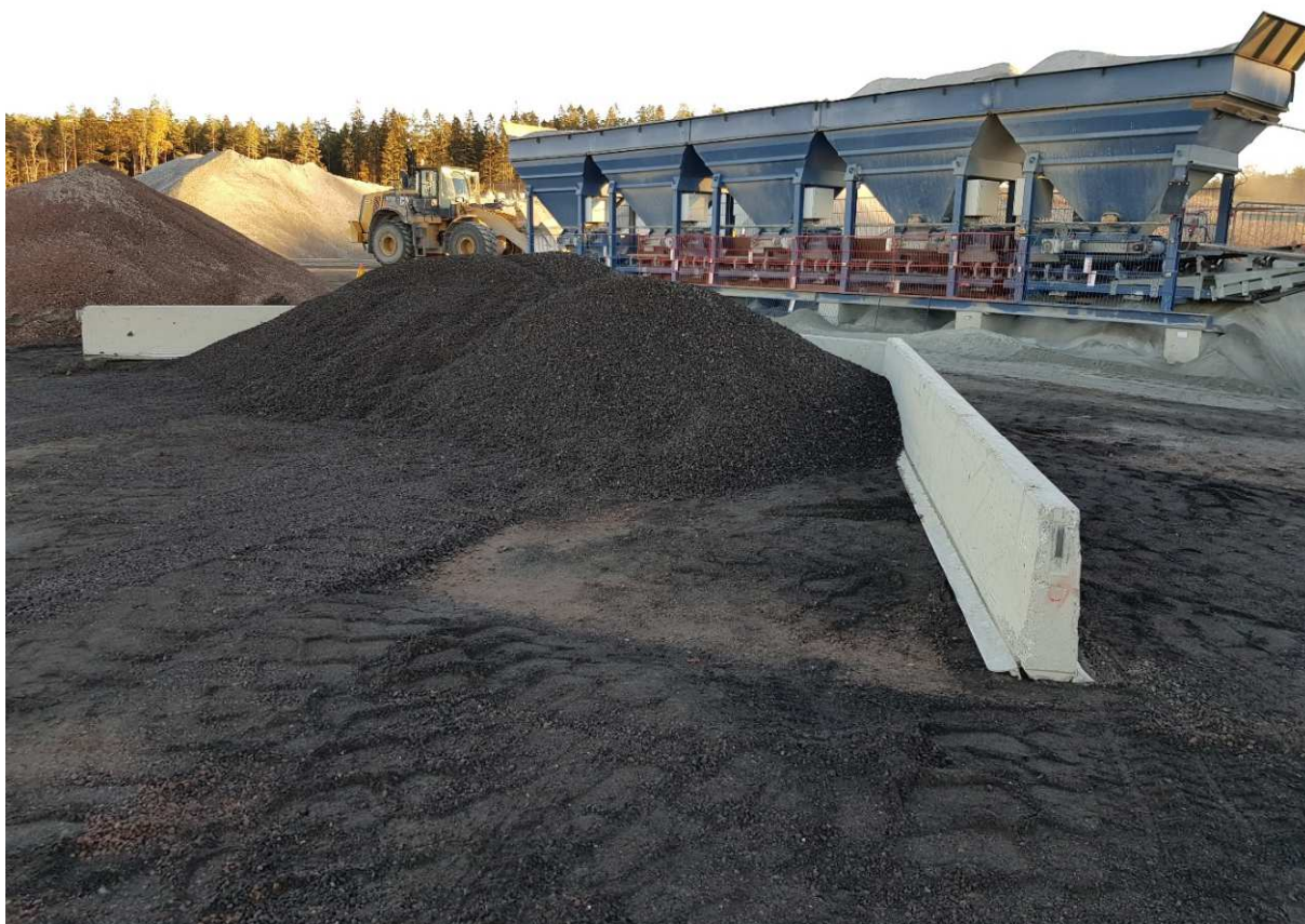
Figur 29. Upplag vid Södertälje asfaltverk med 22 RA 8/16 kkv<7 Vä.
