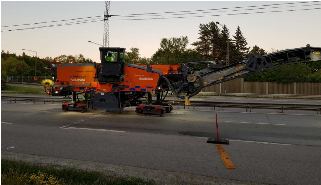
Figur 4. Uppfräsning av högkvalitativ slitlagerbeläggning
